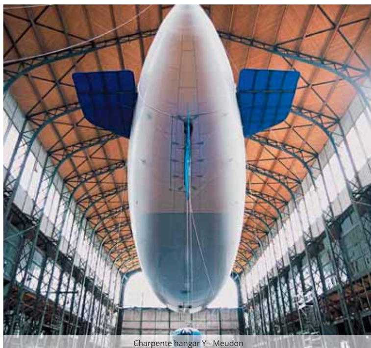
Charpente hangar Y - Meudon
