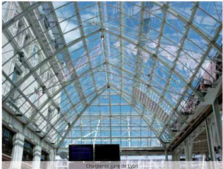
Charpente gare de Lyon
