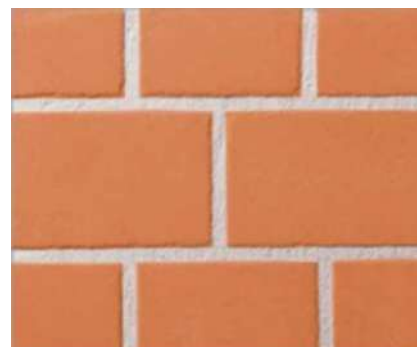
Aspect du revêtement de finition
